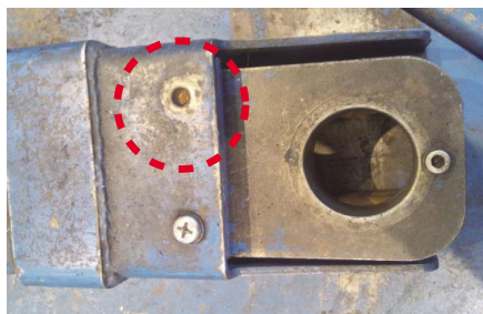
ボルトが外れている
