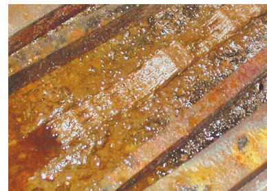
錆が発生した状態
