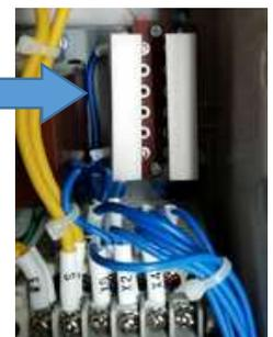
抵抗から「X1」「X2」「24V」の配線が出ており、それぞれシーケンサの「X1」「X2」「S/S」の端子台に結線されています。アーム高さ検知LSを交換する場合はこの抵抗を取り外してください
