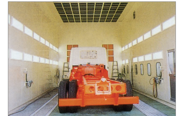
大型トラック用クリーン塗装ブース
